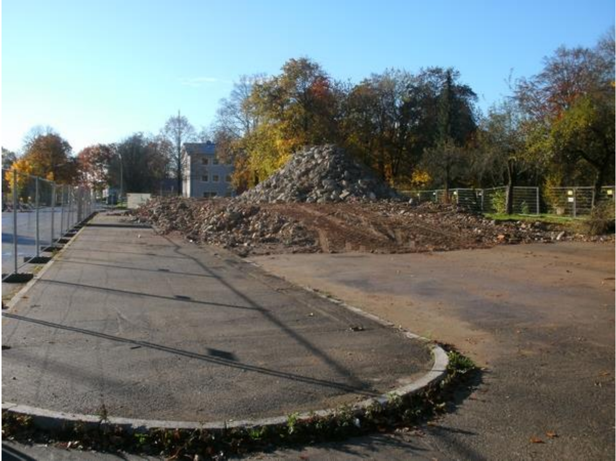
Ein letzter Blick zurück. Das bleibt übrig vom Block 1 nachdem Fenster und Türen, Holz und Stahl ausgesondert wurden.
